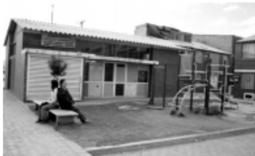
FIGURA 17. GUARDERÍAS – PARQUES. CIUDADELA EL RECREO.
