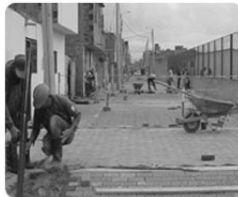
Localidad 8 Kennedy, UPZ 82. Patio Bonito Construcción Tramo Ciclo Ruta Zonal
