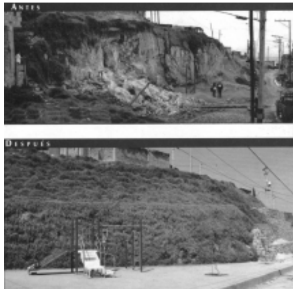
FIGURA 23. CONSTRUCCIÓN DE OBRA PARA MITIGAR EL RIESGO POR DESLIZAMIENTO. BARRIO PLAYÓN PLAYITA. DPAE.
